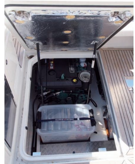
Viel Platz und gut zugänglich: Der Motorenraum (hier: Zugang zur Stb.-Maschine).
